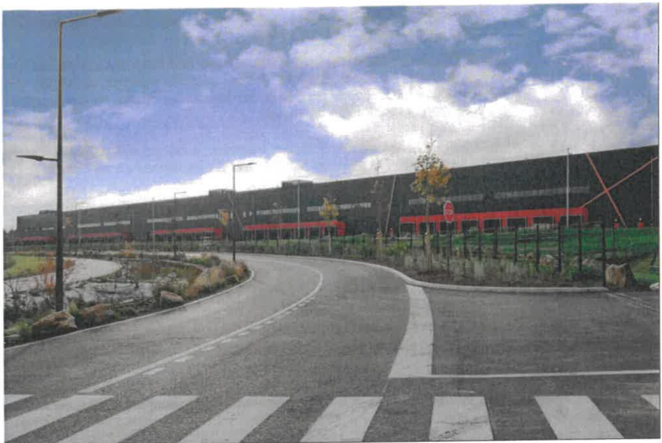
Vue (partielle) du bâtiment existant depuis la voie d'accès de la ZAC
